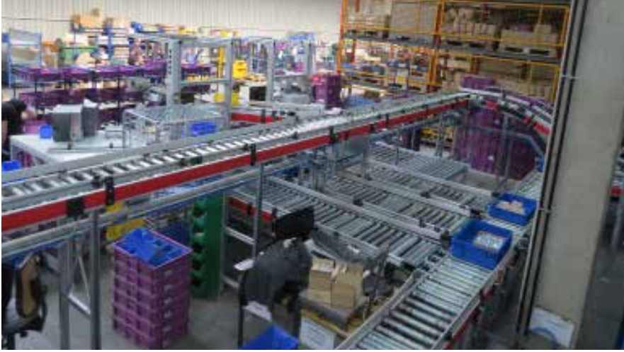
Ein Blick ins Automatische Kleinteilelager von Schaltbau Bode in Kassel: Bis zu 1000 Kommissionierungen am Tag werden hier abgefertigt.
